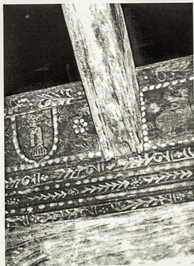
Il soffitto in fase di montaggio
